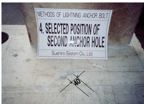
<第2 アンカーボルト孔の穿孔>
