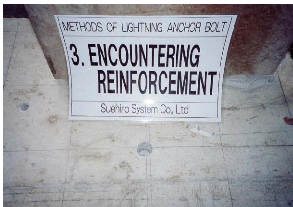
<穿孔位置に鉄筋干渉>
