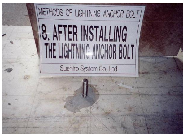
<イナズマアンカーボルト取付>
